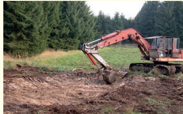
Deswegen sollen neue Gewässermulden angelegt und bestehende Gewässer optimiert werden.
